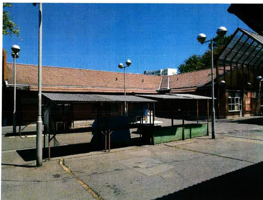
Belső udvari kép
