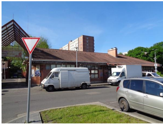
Homlokzat 43031/1 hrsz.-ú ingatlan felől
