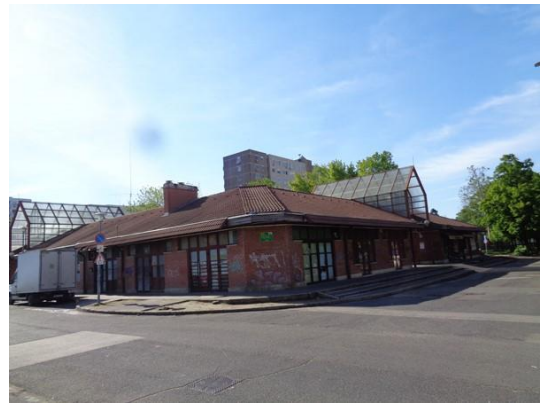
Homlokzat 43031/2 hrsz.-ú ingatlan felől
