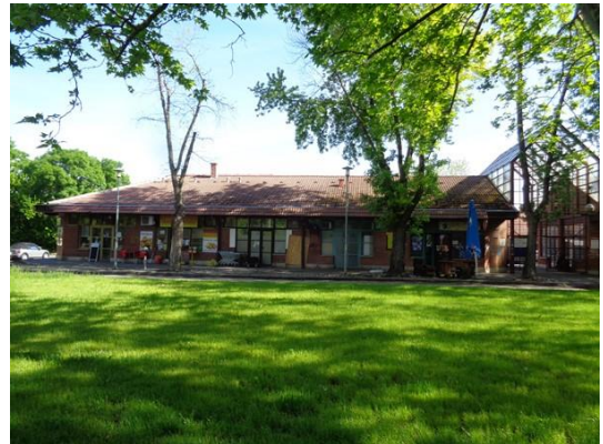
Homlokzat 43015/4 hrsz.-ú ingatlan felől
