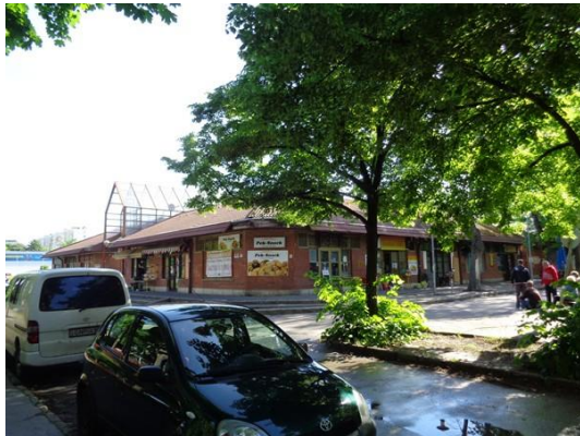
Homlokzat (43259) hrsz.-ú ingatlan felől
