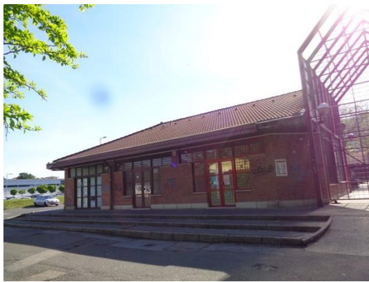
Homlokzat (43259) hrsz.-ú ingatlan felől
