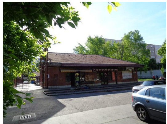
Homlokzat (43259) hrsz.-ú ingatlan felől
