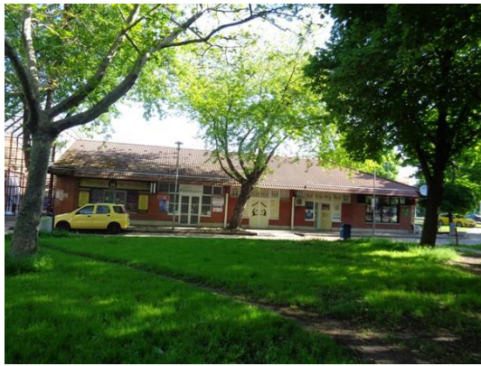
Homlokzat 43015/4 hrsz.-ú ingatlan felől
